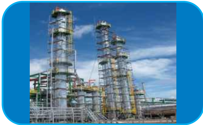
LẮP ĐẶT THIẾT BỊ CÔNG NGHIỆP
