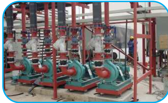
LẮP ĐẶT BƠM CHO HỆ THỐNG BƠM NƯỚC
