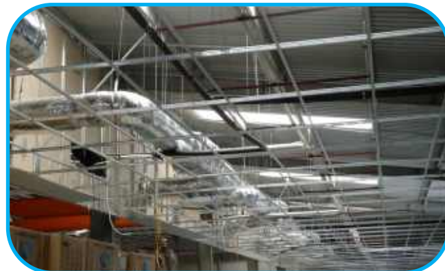
LẮP ĐẶT HỆ THỐNG ĐƯỜNG ỐNG THÔNG GIÓ
