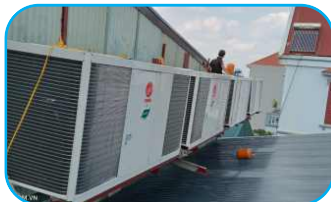
LẮP ĐẶT DÀN NÓNG ĐIỀU HÒA TRUNG TÂM & ĐIỀU HÒA CÔNG NGHIỆP
