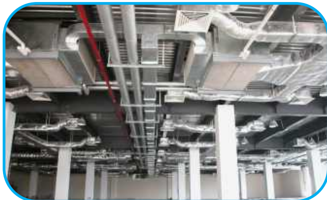
LẮP ĐẶT HỆ THỐNG ĐIỀU HOÀ THÔNG GIÓ
